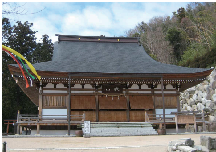
西国第32番札所観音正寺本堂銅板屋根工事 当社施工
